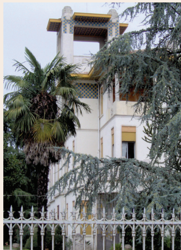
Villa Tretti - Lato sud ovest
