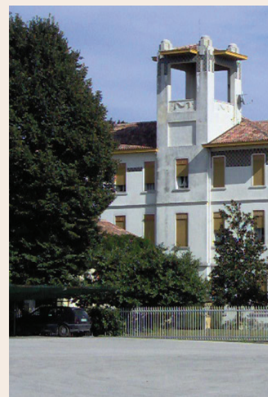
Villa Tretti - Lato ovest
