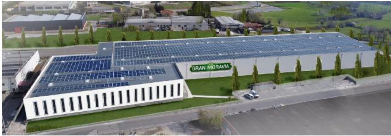
A Cogollo del Cengio: il rendering del nuovo magazzino automatizzato per la stagionatura del Gran Moravia ormai ultimato
